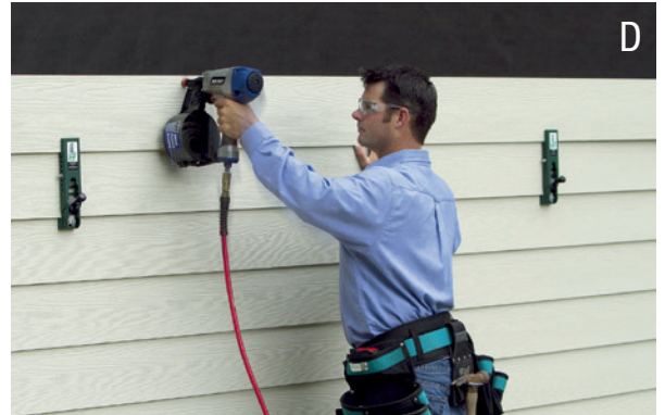
D: Befestigen durch Nageln oder Schrauben (ohne Vorbohren).
