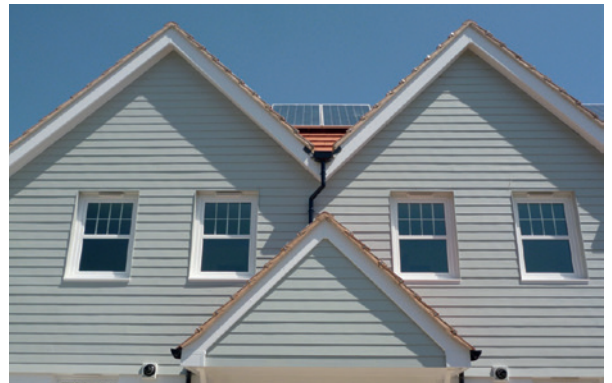
D: Befestigen durch Nageln oder Schrauben (ohne Vorbohren).
